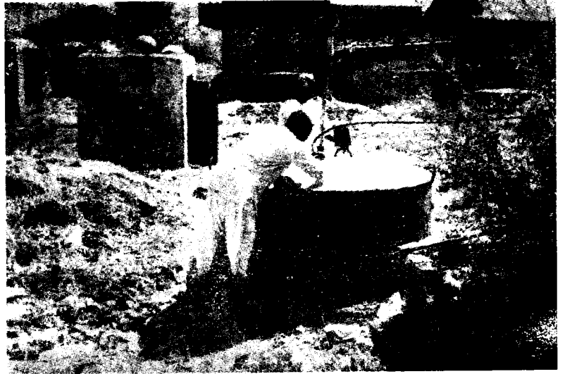
प्रगति का सूचक—गोबर गैस प्लांट
