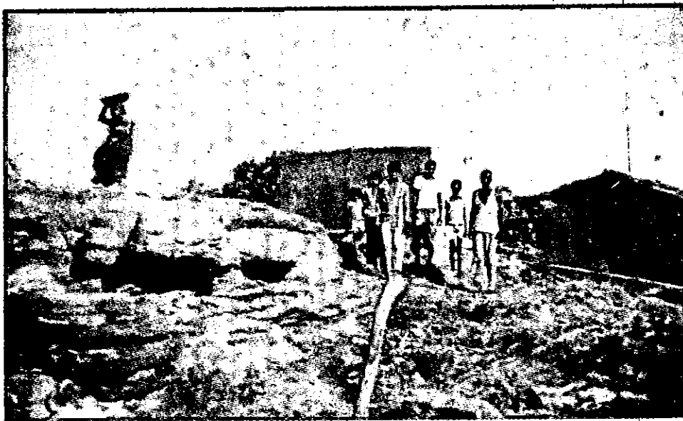
जल योजना ग्राम नोलाव टंकी का निर्माण
