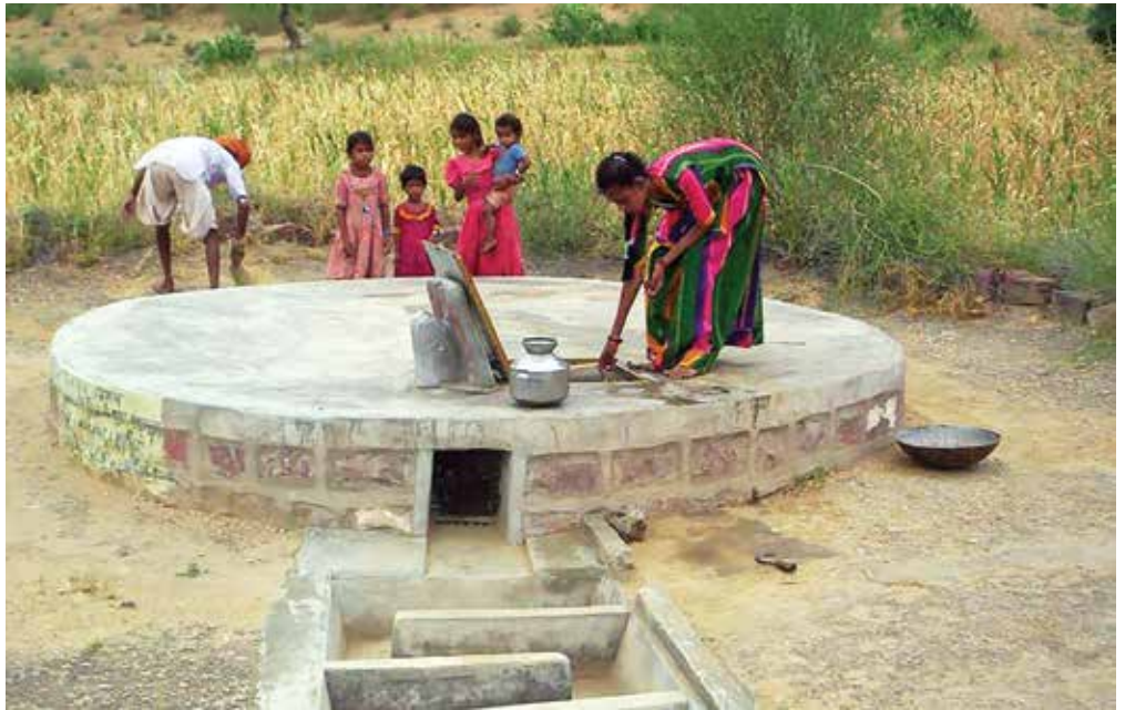
राजस्थान के टंका पूरे गाँव की जल आवश्यकता को पूरा करते थे
