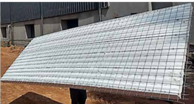
फैक्ट्री निर्मित ईपीएस कोर पैनल और मोटे तार की जाली लगाना
