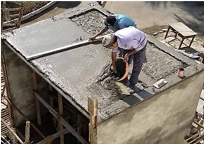
ईपीएस वाले कोर ढांचे और तैयार हो चुके इमारत के मॉडल पर कंक्रीट डालना
